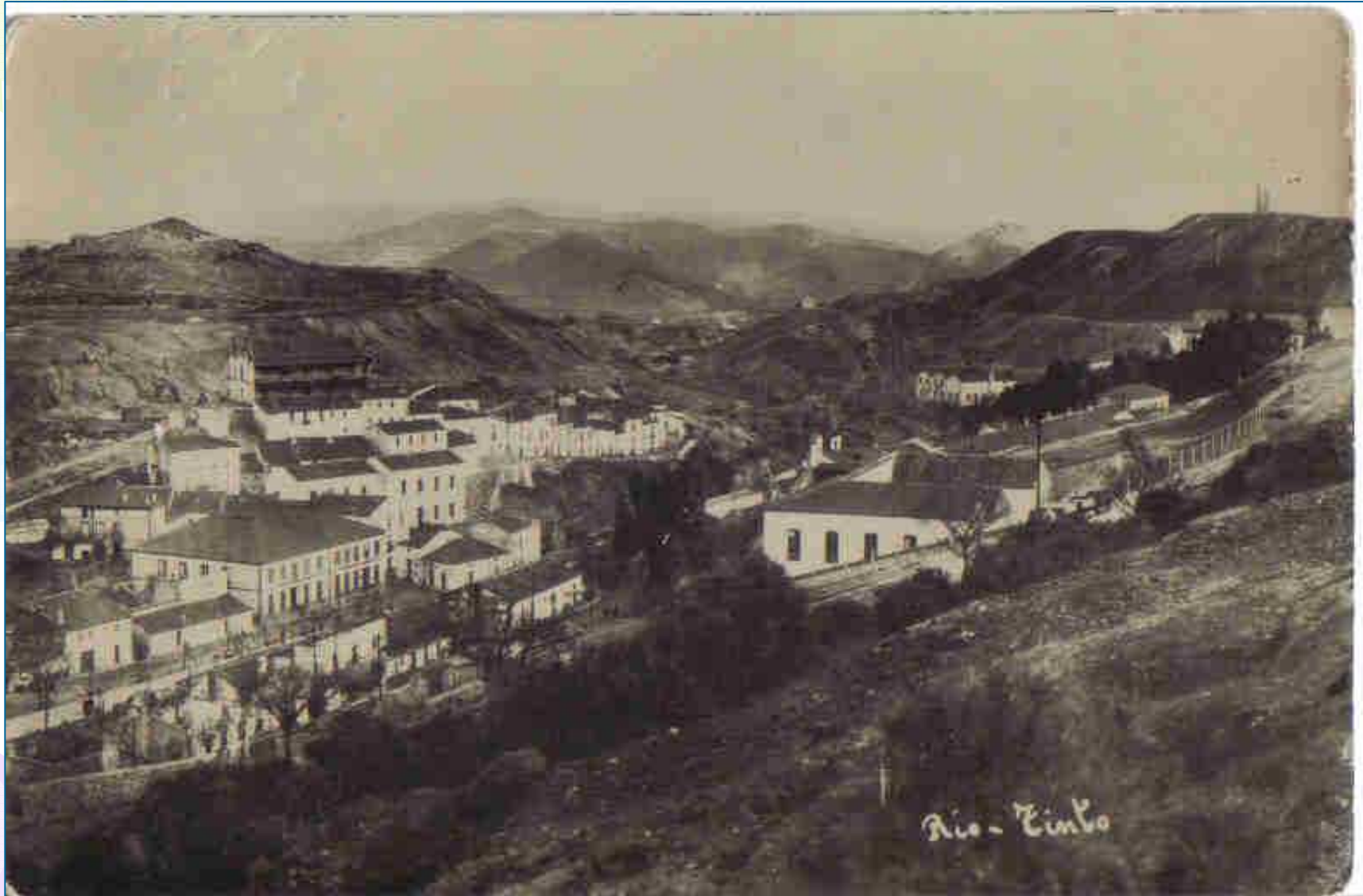
Ríotinto (La Mina)
